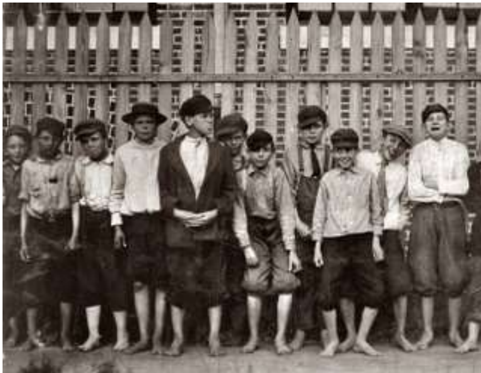
Esperando lograr un puesto en una hilandería en Carolina del Sur. Nótese la pobreza de los niños en sus vestimentas y falta de calzado. FSF.
